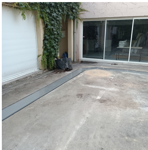
Pose d'un dispositif anti-inondation pour un bâtiment de bureau
